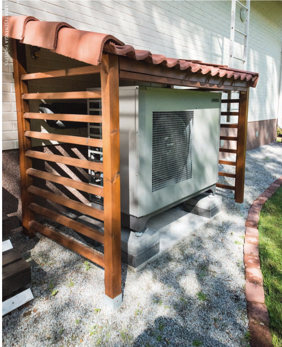
Hybridimuotoisella lämmitysratkaisulla tarkoitetaan öljykattilan ja lämpöpumpun yhdistelmää.
